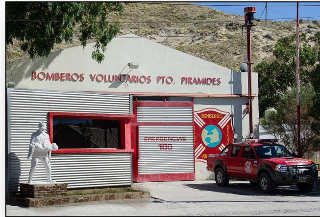
Imagen 8: Cuartel de Bomberos Voluntarios
