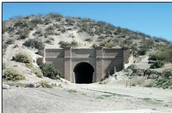
Imagen 3: Salida del Túnel Ferroviario – Gaiman, Chubut
